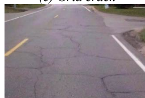
(d) Massive crack
